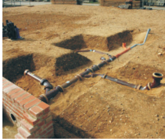
Teststrecke in Kerpen für die Sachkundigen- schulung der DWA zur Dichtheitsprüfung von Grundstücksentwässerungsanlagen
