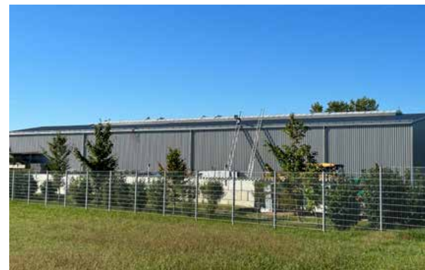
Neue Lagerhalle am Bauhof mit PV-Anlage
