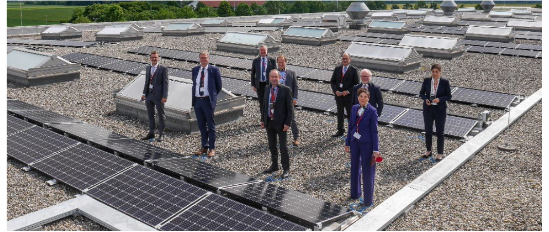
Einweihung PV-Dachanlage Fa. Canon
